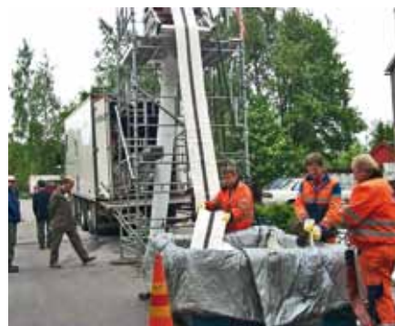
Ryc. 6. Odnowa przewodu kanalizacyjnego w Helsinkach w Finlandii przy użyciu technologii CIPP
