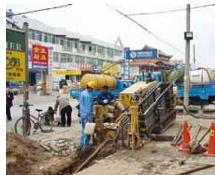
Ryc. 8. Budowa podziemnych linii elektroenergetycznych w Szanghaju w Chinach
