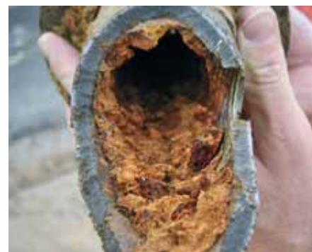
Ryc. 2. Inkrustacja żeliwnego przewodu wodociągowego o średnicy 100 mm w Campinas w Brazylii
