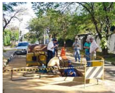
Ryc. 3. Wymiana przewodu wodociągowego w Brazylii za pomocą technologii bezwykopowej wymiany ( pipe bursting )
