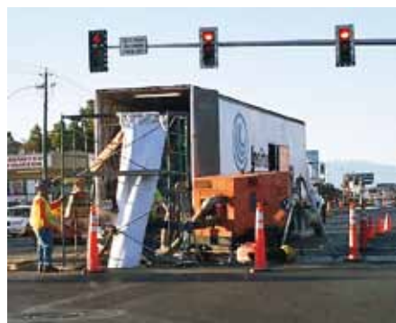
Ryc. 4. Bezwykopowa odnowa przewodu kanalizacyjnego w Las Vegas w stanie Nevada przy użyciu technologii utwardzanych powłok żywicznych (CIPP)
