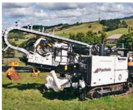
Ryc. 5. Budowa wodociągu w Nowej Zelandii przy użyciu technologii HDD
