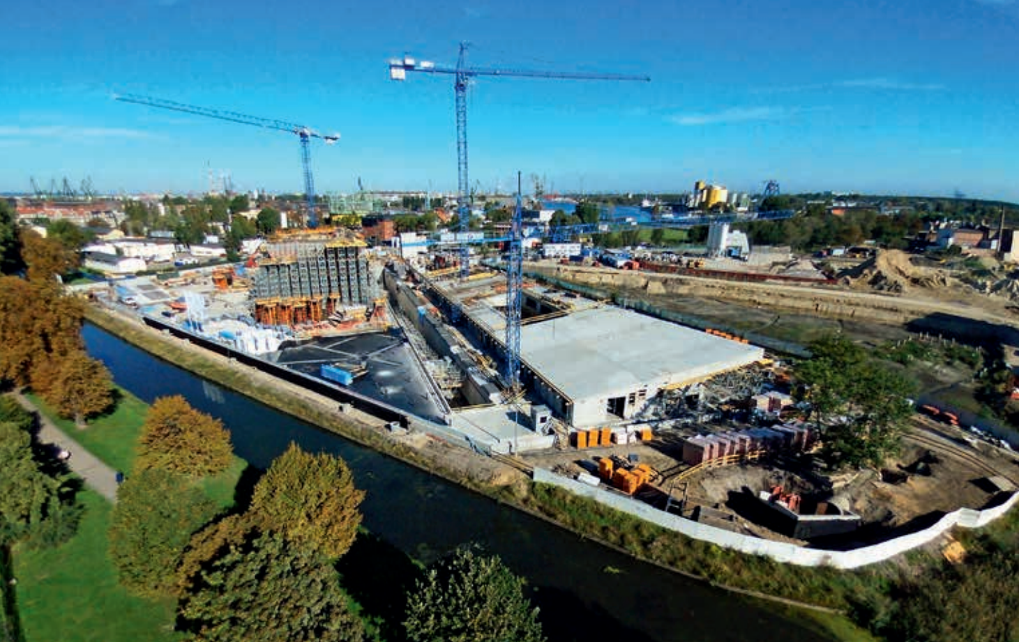
Widok na plac budowy od strony Starego Miasta
