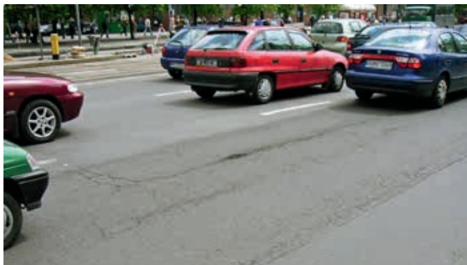
Droga przed remontem, fot. Instytut Badawczy Dróg i Mostów
