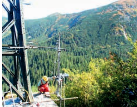
Wzmacnianie fundamentów nowej kolejki na Kasprowy Wierch
