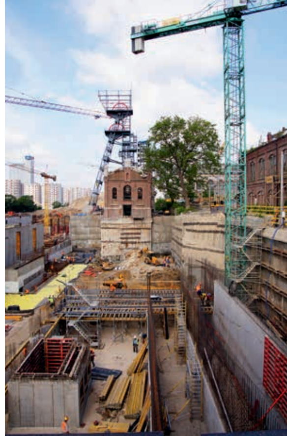
Zabezpieczenie głębokiego wykopu w trakcie budowy Nowego Muzeum Śląskiego w Katowicach
