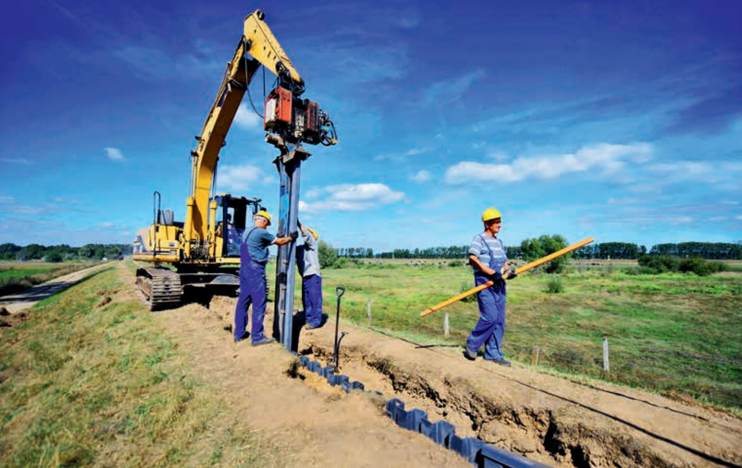
Ryc. 1. Doszczelnienie wału przeciwpowodziowego rzeki Warty (Sieradz)
