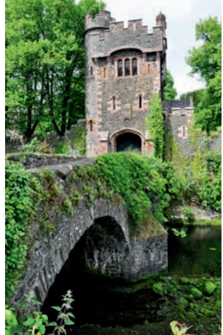
Ryc. 4. Średniowieczny, kamienny, dwuprzęsłowy most łukowy z basztą obronną w Glenarm
