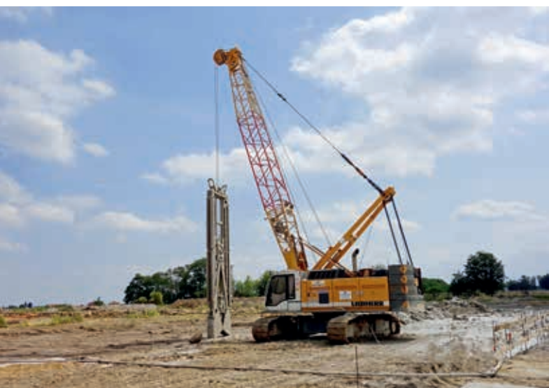
Wykonywanie przegrody typu slurry trench w Duchnicach, fot. Soletanche Polska Sp. z o.o.
