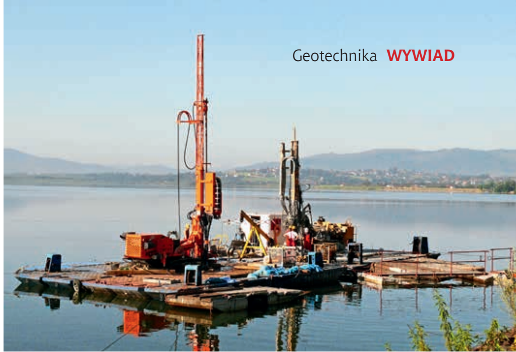
Budowa wieżowego ujęcia wody w czaszy zbiornika Tresna
