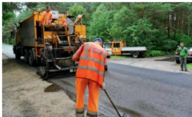
Układanie mikrodywanika, fot. Zarząd Dróg Wojewódzkich w Bydgoszczy
