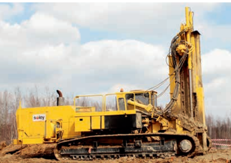
Trencher wykonujący przesłonę przeciwfiltracyjną, Soley Sp. z o.o.
