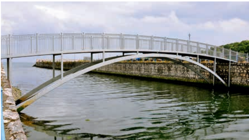
Ryc. 2. Stalowa, łukowa kładka dla pieszych w Glenarm
