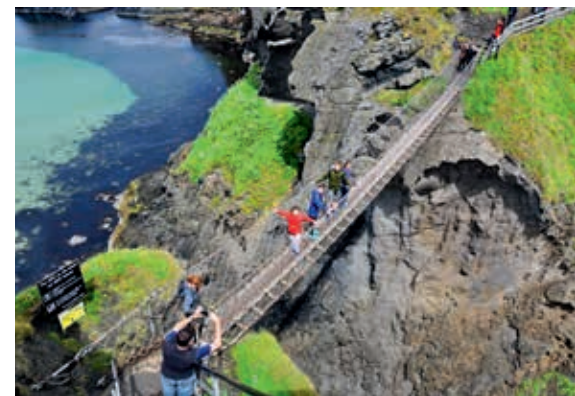
Ryc. 5. Wiszący most linowy Rope Bridge w Carrick-a-rede
