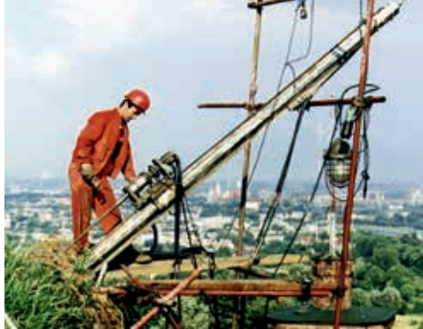
Prace zabezpieczające Kopiec Kościuszki
