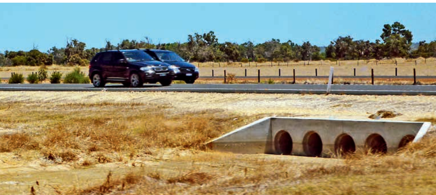
Przepust wielootworowy w ciągu autostrady w zachodniej Australii, fot. A. Wysokowski
