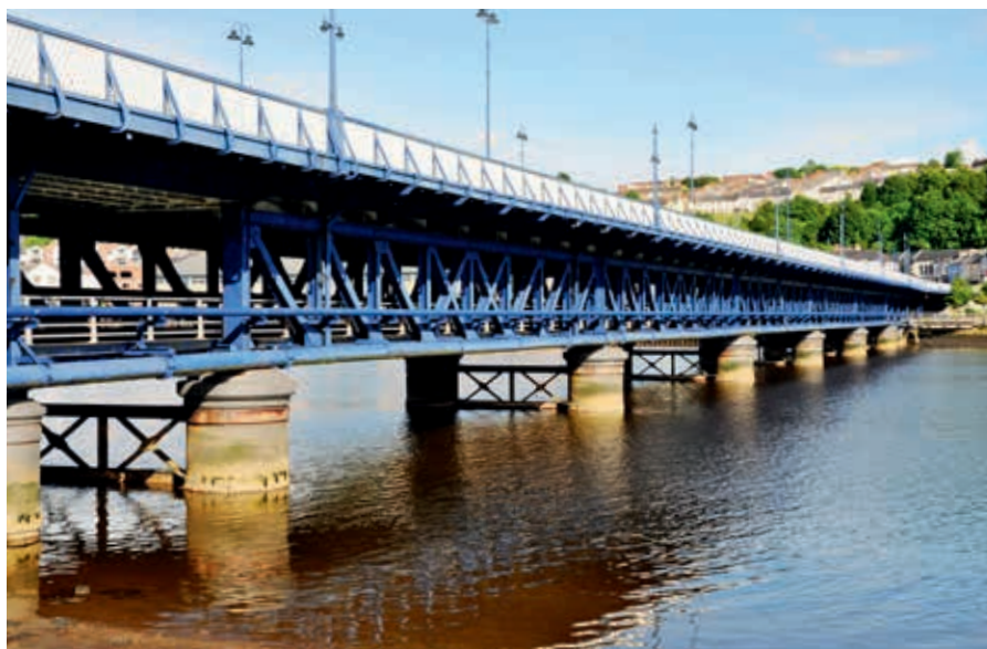
Ryc. 8. Dwupoziomowy, stalowy, ośmioprzęsłowy most drogowy przez rzekę Foyle w Londonderry
