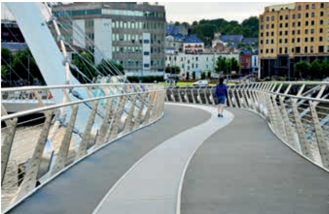
Ryc. 10. Detal kładki Pokoju
