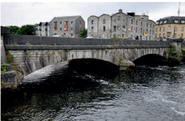
Ryc. 20. Kamienny, łukowy, dwuprzęsłowy most William O'Brien w Galway
