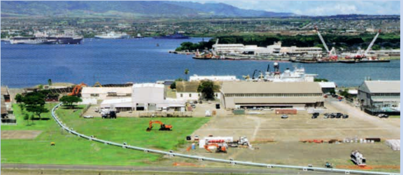
Ryc. 2. Rurociąg ze zgrzewanego PVC przed zainstalowaniem [5]
