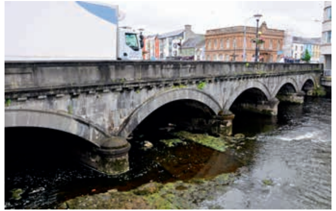
Ryc. 13. Kamienny, pięcioprzęsłowy most łukowy z 1850 r. w Sligo
