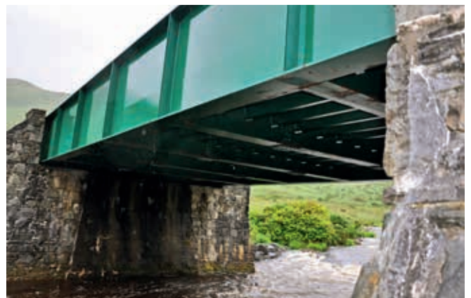
Ryc. 24. Stalowy most belkowy przez rzekę Errif w regionie Connemara
