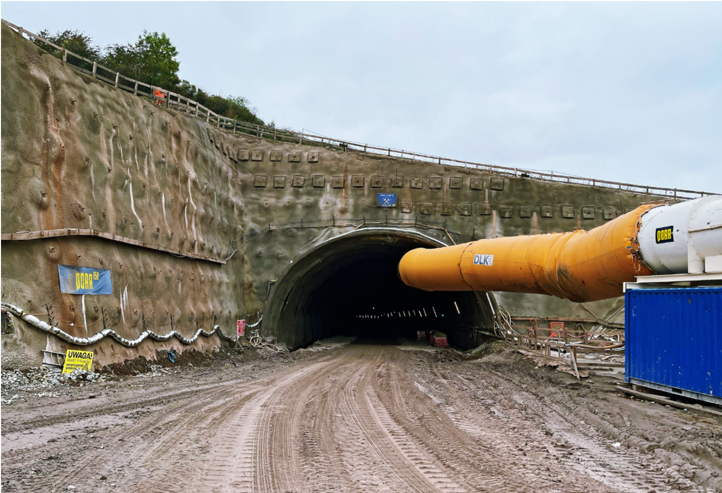
Budowa tunelu na drodze S3 Bolków – Kamienna Góra, fot. nbi media
