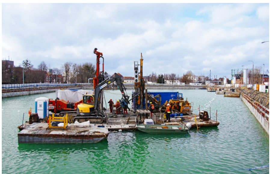
Budowa Muzeum II Wojny Światowej w Gdańsku – kotwienie płyty dennej mikropalami iniekcyjnymi
