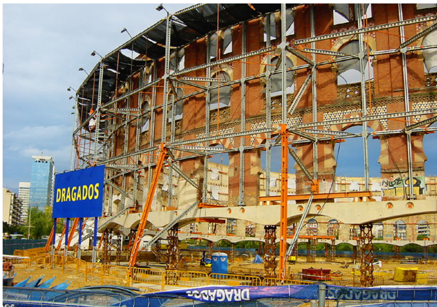
Dawna arena do walk byków w Barcelonie – obiekt został tymczasowo podchwycony na mikropalach
