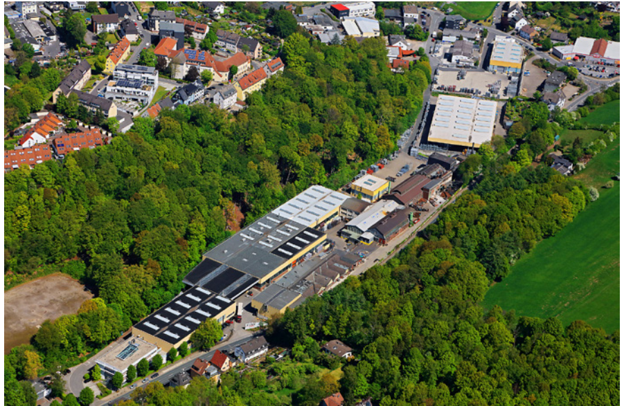
Siedziba i zakład produkcyjny Friedr. Ischebeck GmbH w Ennepetalu w Niemczech
