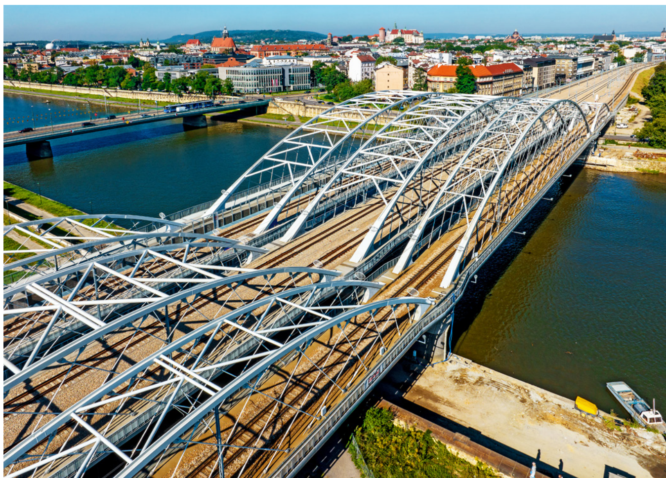
Mosty kolejowe nad Wisłą w Krakowie – integracja infrastruktury kolejowej z miejskimi bulwarami i ciągami pieszo-rowerowymi, fot. kilhan, Adobe Stock
