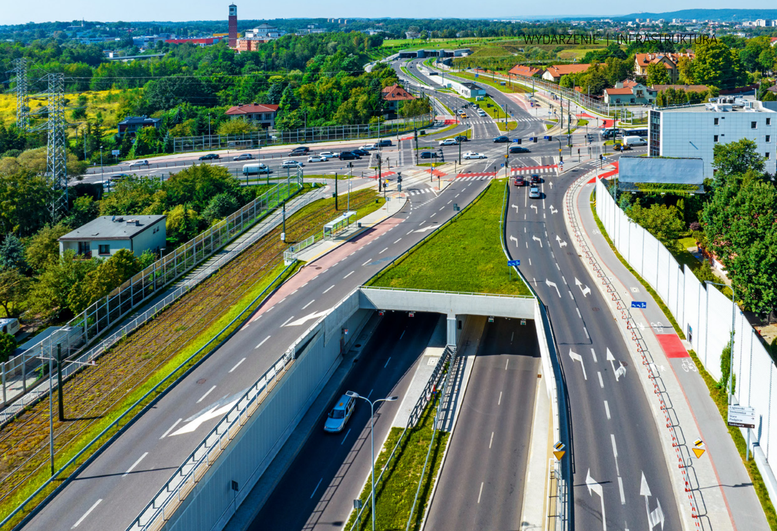
Trasa Łagiewnicka w Krakowie – przykład integracji miejskich obiektów infrastruktury z drogami, tramwajem i tunelami, fot. kilhan, Adobe Stock
