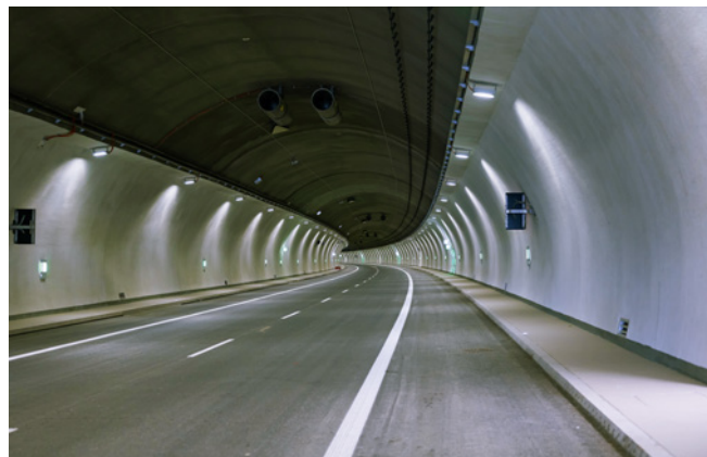
Zabezpieczenie ogniochronne konstrukcji tunelu pod górą Luboń Mały w ciągu S7 Lubień - Rabka-Zdrój systemem ogniochronnym Fendolite MII
