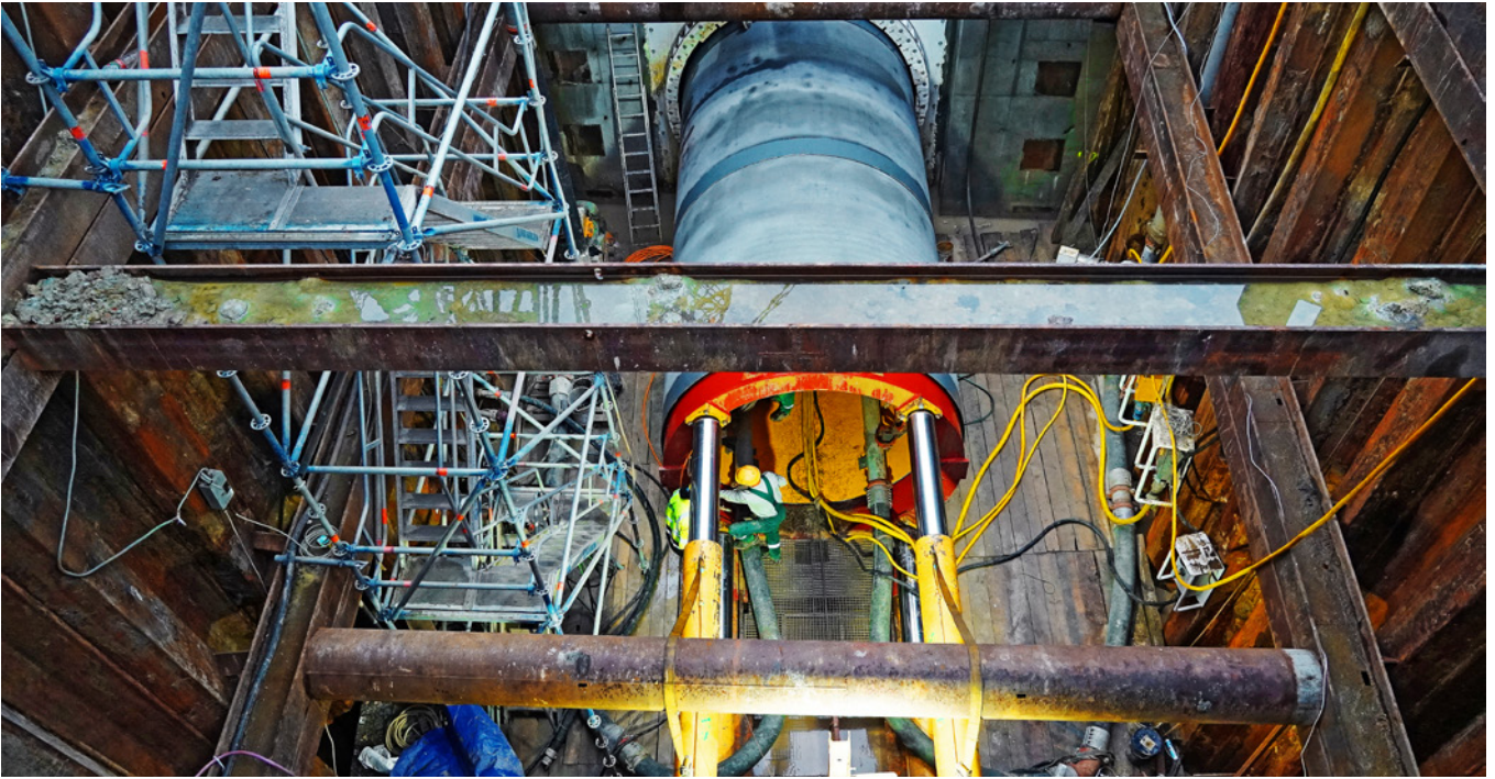
Komora startowa kolektora Mokotowskiego Bis, fot. Miejskie Przedsiębiorstwo Wodociągów i Kanalizacji w m.st. Warszawie SA
