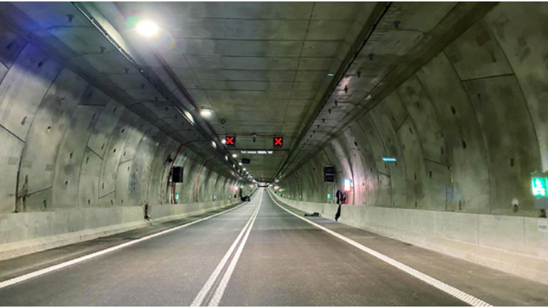
Tunel pod Świną, Świnoujście, fot. Gmina Miejska Świnoujście
