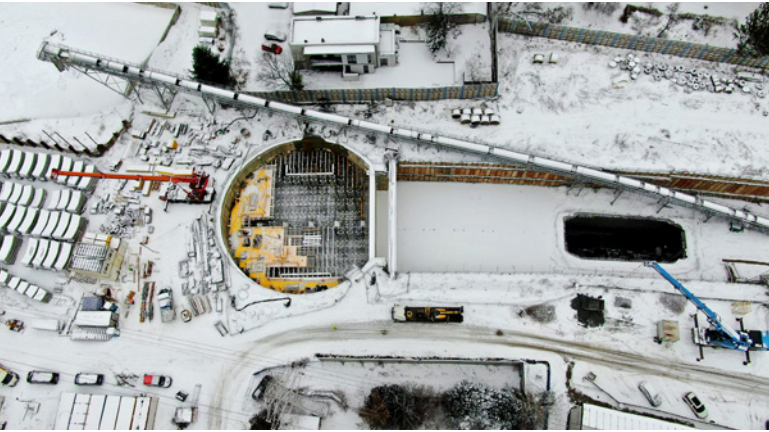
Tunel średnicowy – widok na budowę komory Stolarska, fot. PKP PLK S.A.
