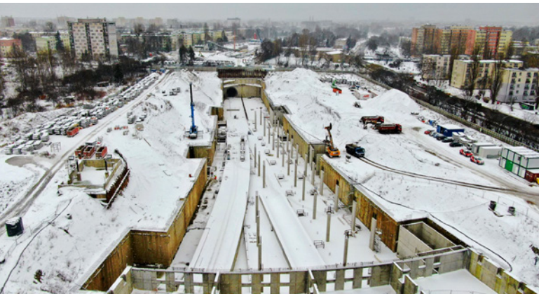
Tunel średnicowy – widok na budowę stacji Łódź Koziny, fot. PKP PLK S.A.
