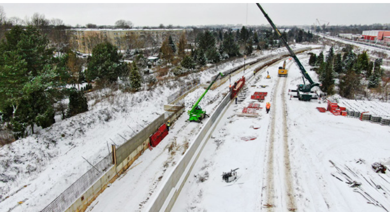
Tunel średnicowy – widok na budowę tuneli w kierunku stacji Łódź Kaliska, fot. PKP PLK S.A.
