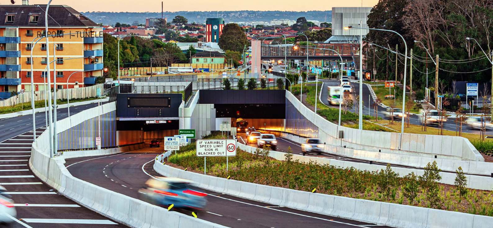
Rozelle Interchange – ostatni etap projektu Westconnex, fot. WestConnex
