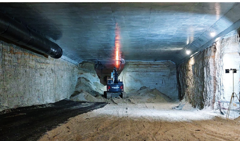
Tunel w Zielonkach, Północna Obwodnica Krakowa, fot. GDDKiA
