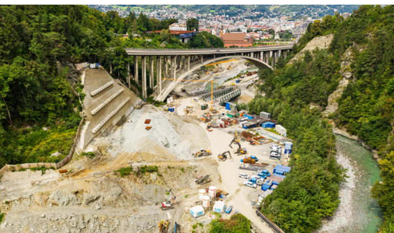
Brenner Base Tunnel, fot. Galleria di Base del Brennero Brenner Basistunnel BBT SE
