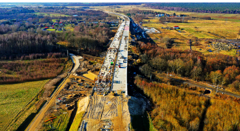
Estakada w ciągu drogi S6, obwodnica Sianowa, fot. GDDKiA
