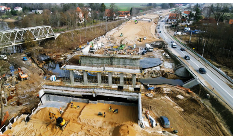
Budowa drogi ekspresowej S16 Borki Wielkie – Mrągowo, fot. GDDKiA
