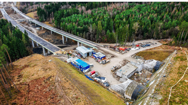
Budowa drogi S1 Przybędza – Milówka, fot. GDDKiA
