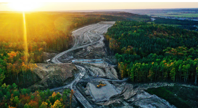
Budowa drogi S6 w województwie pomorskim, fot. GDDKiA
