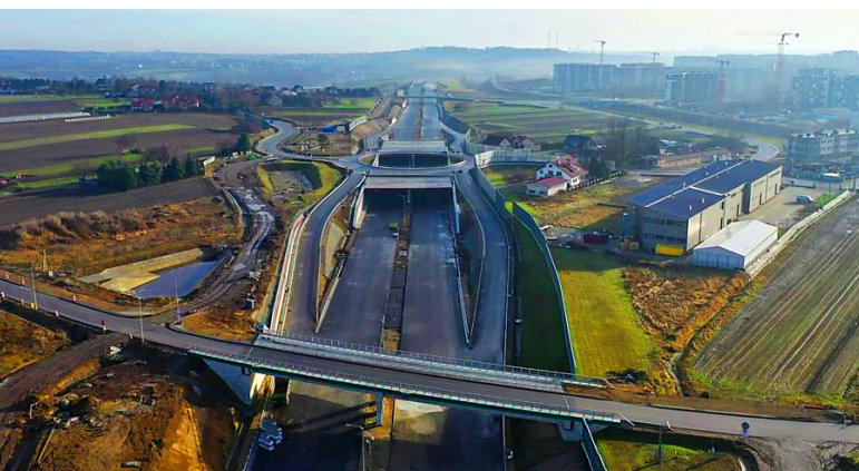
Budowa Północnej Obwodnicy Krakowa, S52, fot. GDDKiA
