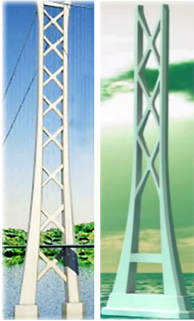
Ryc. 11. Wizja architektoniczna pylonów o wysokości 420 m; źródło: [16]
