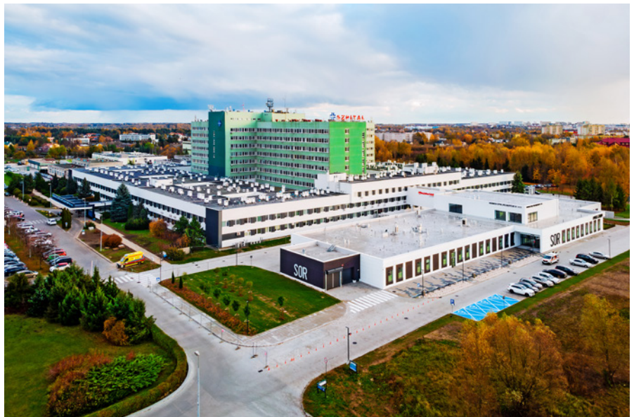
SOR Mazowieckiego Szpitala Specjalistycznego w Radomiu
