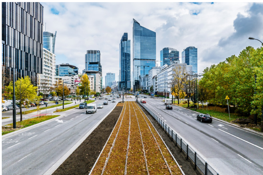
Linia tramwajowa na ul. Kasprzaka w Warszawie
