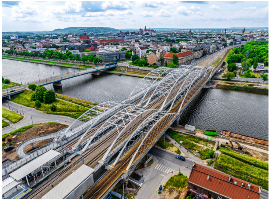
Mosty kolejowe na linii E30 w Krakowie
