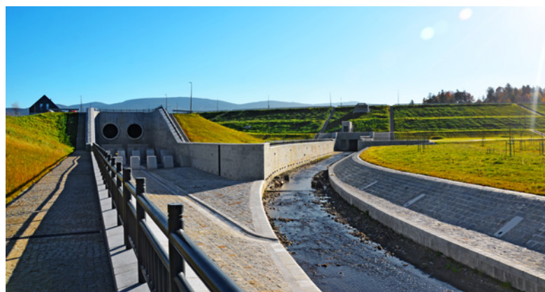
Suchy zbiornik przeciwpowodziowy w Roztokach, fot. PORR SA
