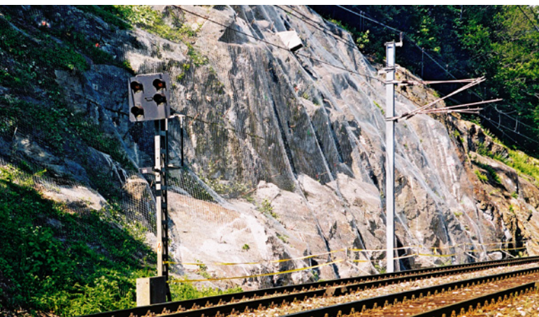
Zabezpieczenie skarp nad linią kolejową, fot. BRUGG
