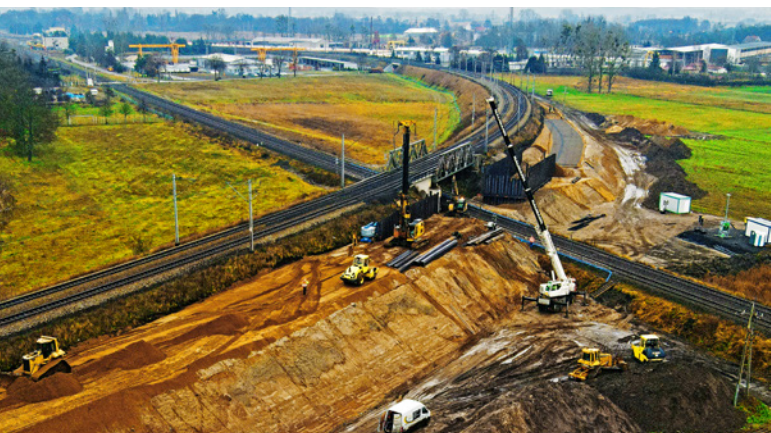
Bajpas kolejowy na LK351, fot. PORR SA
