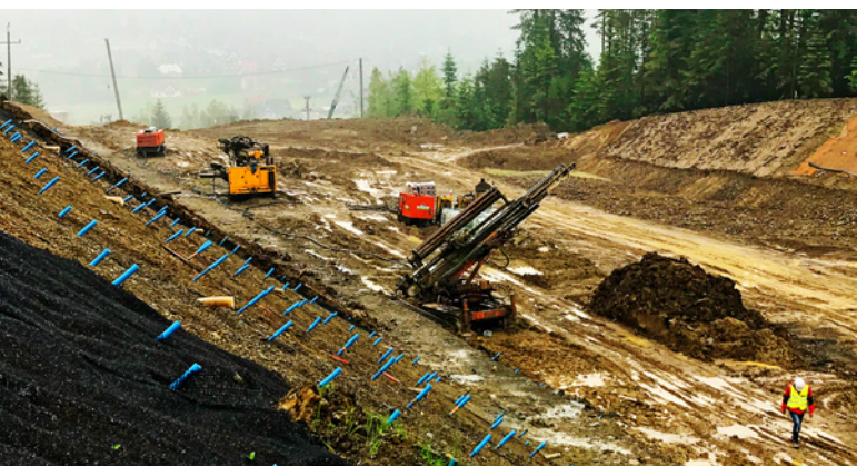
Zabezpieczenie skarp na S7, fot. Ischebeck TITAN Polska
