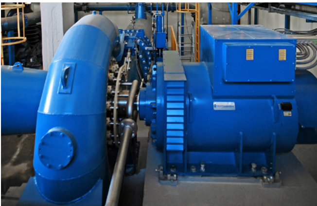
Turbina z generatorem w komorze KP3
