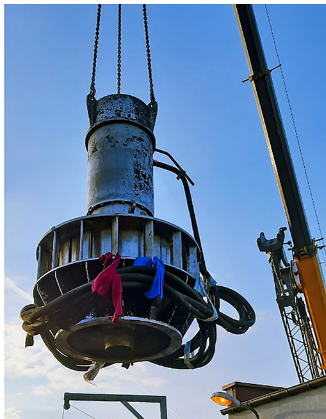
Demontaż turbiny pracującej na grawitacyjnym wypływie ścieków oczyszczonych w celu wykonania czynności serwisowych
