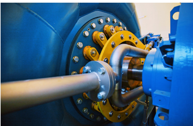
Układ regulacji łopat turbiny
