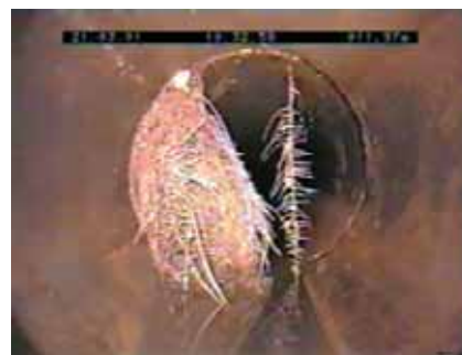
Rys. 31. Korzenie w części wypełniającej przekrój poprzeczny kanału [11]
