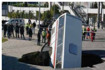
Rys. 3. Autobus po zapadnięciu się w obszar pustki powietrznej nad nieszczelnym kanałem w Lizbonie [10]
