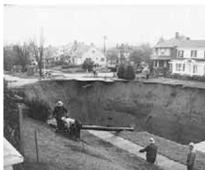
Rys. 2. Zapadlisko powstałe po zawaleniu się kanału w Seattle w 1957 r. [10]
