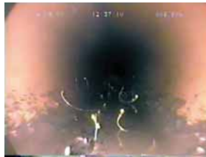
Rys. 34. Kielkujące rośliny w dnie kanału [11]
