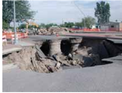
Rys. 8. Widok na zachodnią część zapadliska w Tucson [10]
