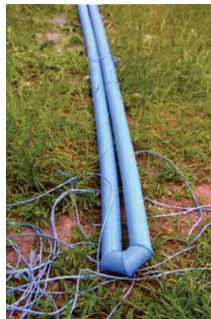
Fot. 2. Przygotowanie U-rurki z tworzywa sztucznego (najczęściej PE) zapuszczanej do odwiertu
