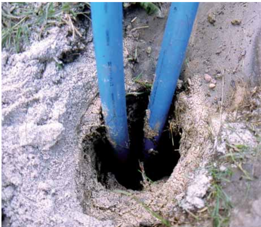
Fot. 3. Wyprowadzenie U-rurki wymiennika ciepła z odwiertu
