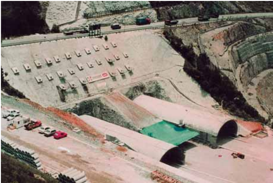
Plac budowy z widokiem na przedtunele: wschodni i zachodni. Projekt Cheung-Ching, Hongkong
