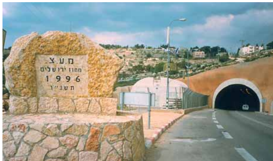
Wlot do tunelu Har Gilo
