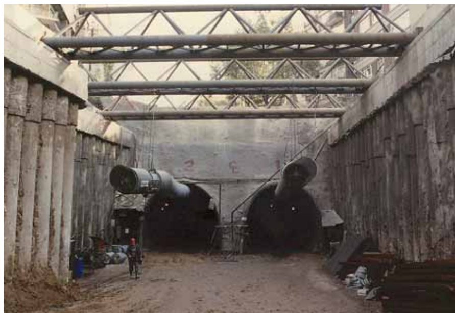
Ankara – wloty do tuneli szlakowych do tuneli metra ze stacji Demitrepe
