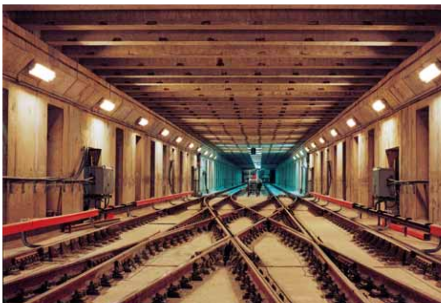
Warszawskie metro – komora rozjazdów
