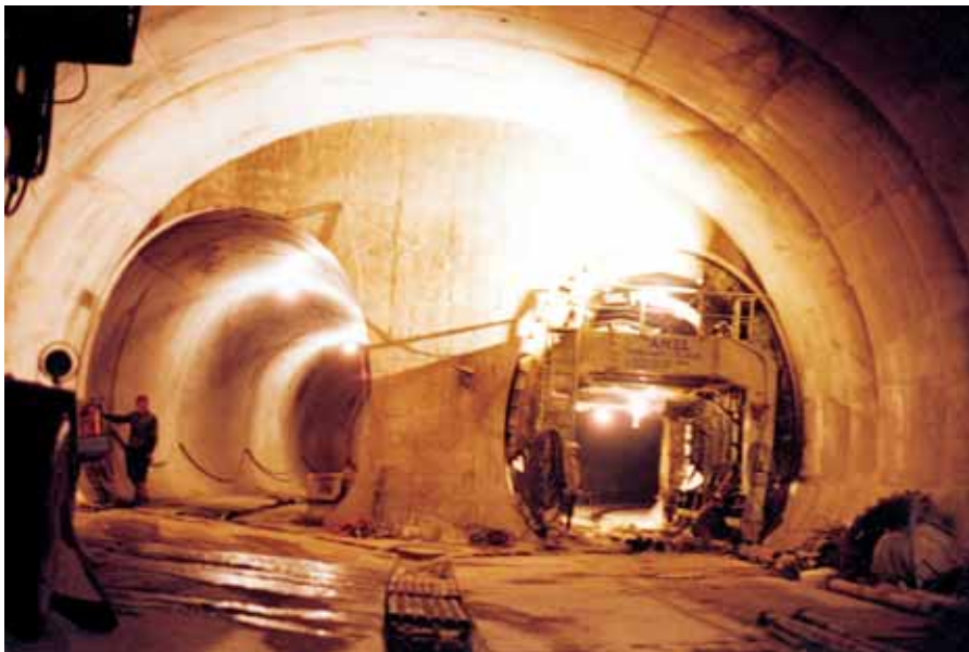
Drażenie tunelu szybkiej kolei podziemnej w Ankarze
