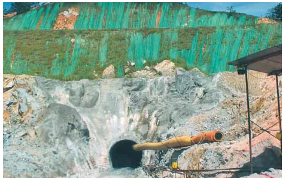
Wlot tunelu zrzutowego wody dla zbiornika Sungai Kelinchi, Malezja
