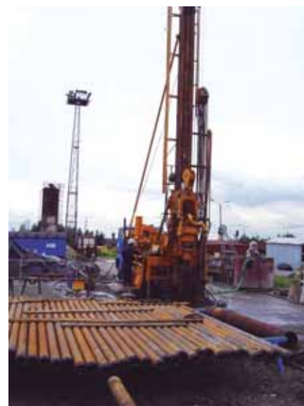
Wiercenie otworu podszadzkiowego
