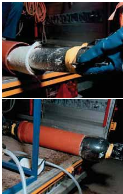
Rys. 14. Pokazowa naprawa fragmentu rurociągu krótkim rękawem [12]
