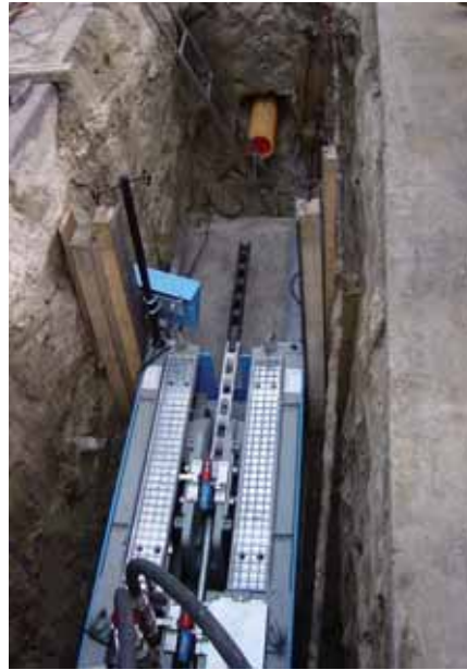
Rys. 3. Wciągarka hydrauliczna wraz ze stacją napędową [23]
