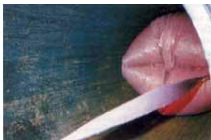
Rys. 12. Wywijanie się powłoki Paltem w trakcie jej wprowadzania do odnawianego gazociągu [6]
