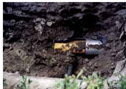
Rys. 19. Miejsce włączenia przyłącza przy przejściu głowicy kruszącej oraz rury PE przez wykop punktowy [20]
