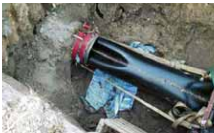
Rys. 10. Rewersja rury Compact SlimLiner [19]
