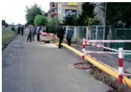
Rys. 20. Jeden z etapów odnowy gazociągu w Poznaniu [20]
