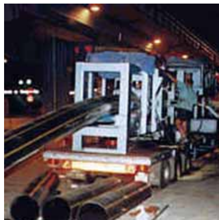
Rys. 18. Urządzenie redukujące przekrój rury PE w czasie nocnej realizacji prac [25]
