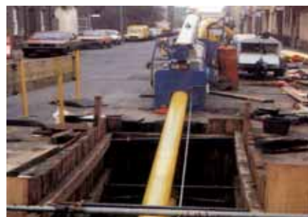
Rys. 7. Urządzenie zmniejszające przekrój rury PE w metodzie Swagelining [6]
