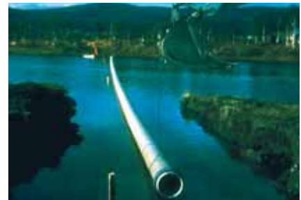
Rys. 12. Wprowadzanie zmontowanej rury [3]
