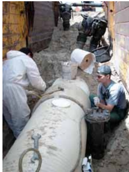
Rys. 7. Wykwalifikowany personel wykonujący połączenie wtryskowe, odporny na działanie sił osiowych rurociąg ciśnieniowy Buxtehude-Hamburg DN 700 PN 10
