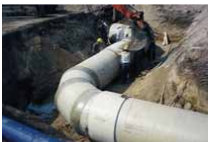
Rys. 6. DN 1400 PN 10, projekt rurociągu odpornego na działanie sił osiowych Zalew Leuna, wykop otwarty w Geiseltal z rurociągiem łączonym za pomocą połączenia wtryskowego
