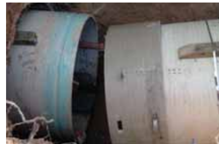
Rys. 13. Montaż rur łącznikiem blokowanym przed wsunięciem do starego rurociągu
