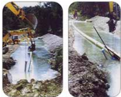
Rys. 5. Połączenie blokowane klinowo, DN 400 PN 16, Nösiwag-A
