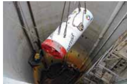
Rys. 1. Głowica do mikrotunelowania opuszczana do komory startowej [7]
