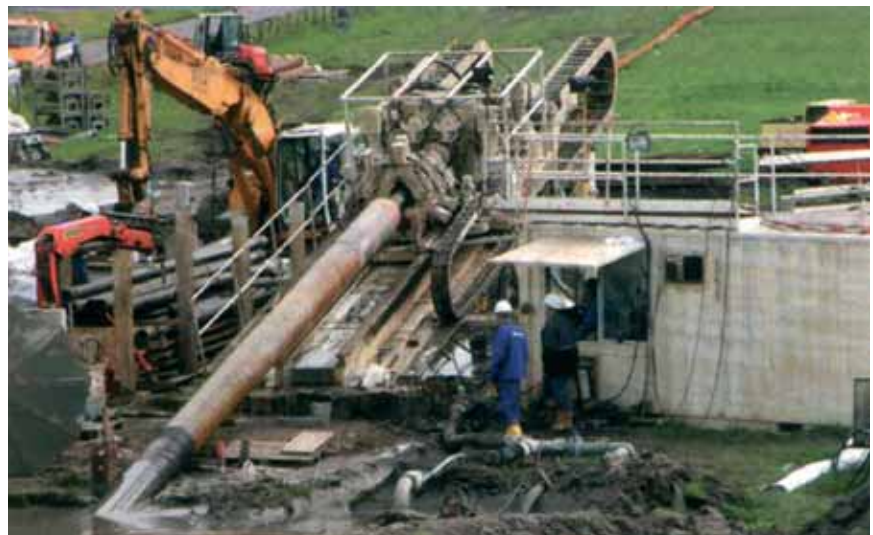
Rys. 2. Prace przewiertowe na brzegu południowym [1]
