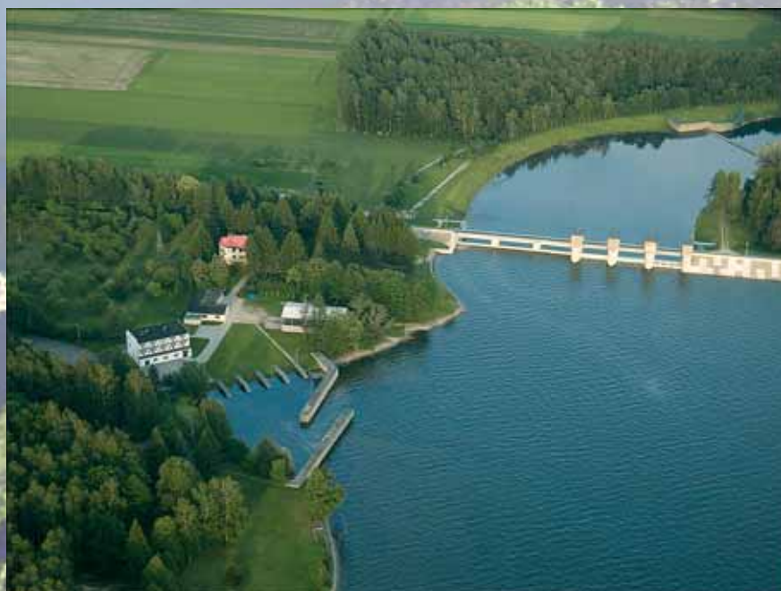
Przelew burzowy zapory w Goczałkowicach
