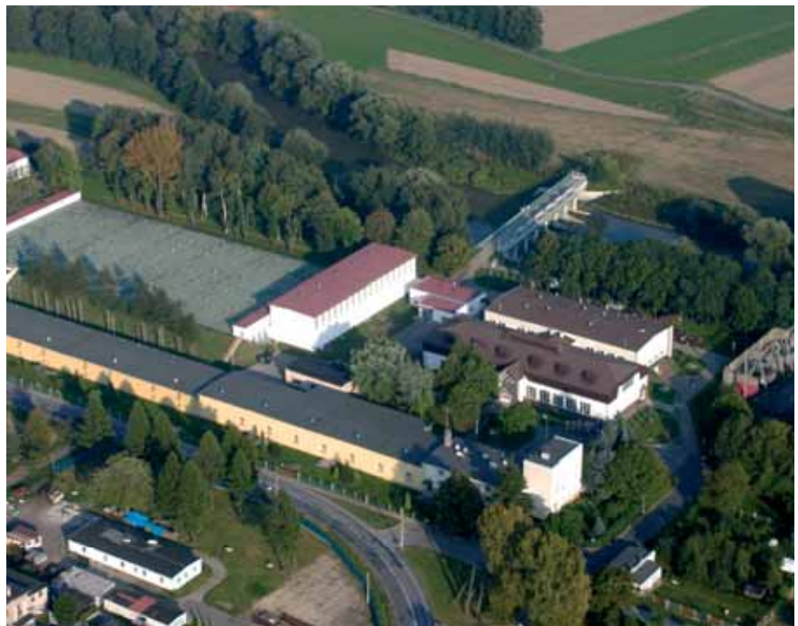
Stacja Uzdławiania Wody w Strumieniu
