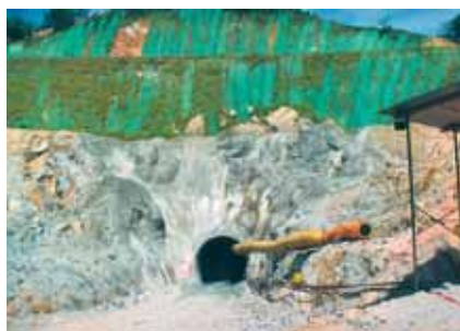
Wlot tunelu zrzutowego wody dla zbiornika Sungai Kelinchi, zrealizowany przez PeBeKa SA w Malezji
