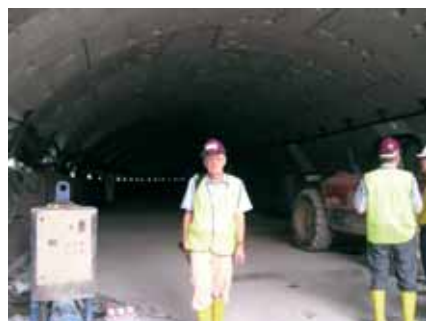
Autor sprawozdania w górnej części tunelu
