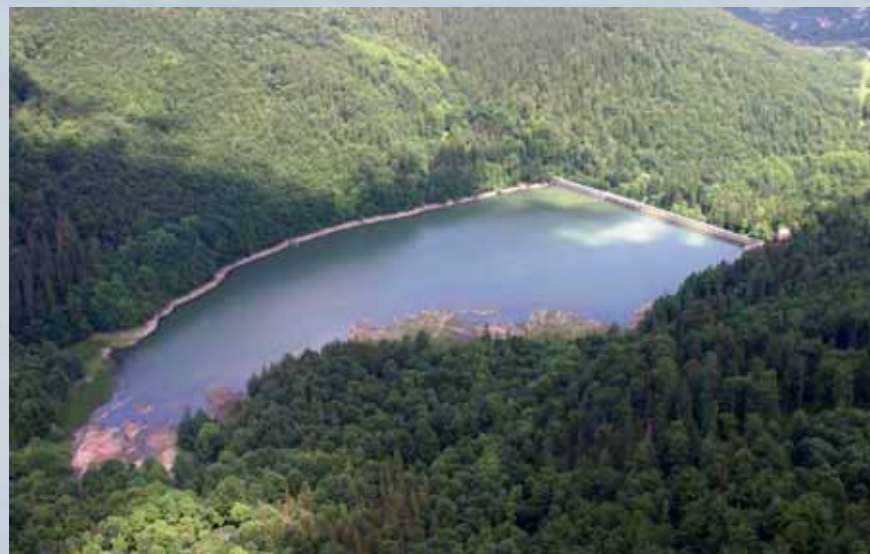
Zbiornik wodny na potoku Wapienica, poniżej którego jest usytuowana stacja uzdatniania wody
