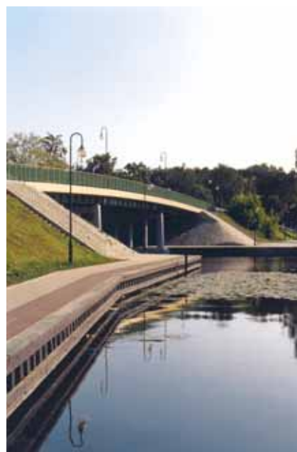
Fot. 2. Zastosowanie grodzic przy nabrzeżach
