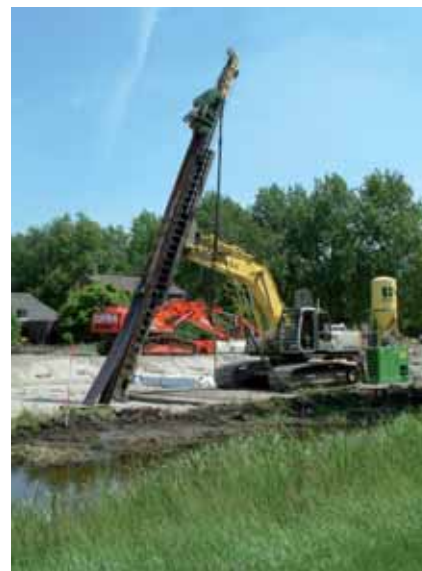
Fot. 5. Kafar do instalacji ścianki szczelnej
