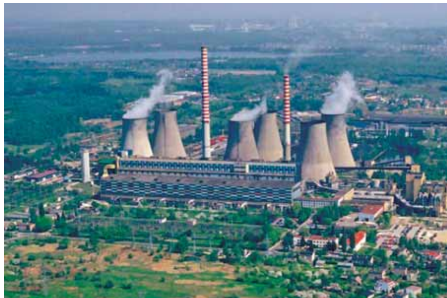
Elektrownia Łagisza w Będzinie
