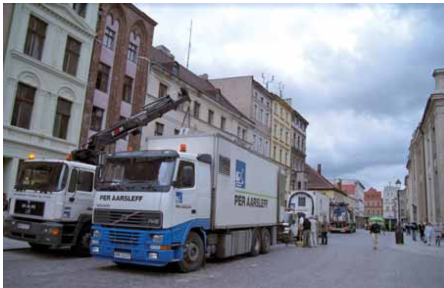
Renowacja rurociągu w Toruniu
