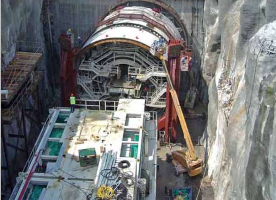
Rys. 1. Kolektor deszczowy SMART o średnicy zewnętrznej 12,8 m i długości 9,7 km w miejscu budowy komory wentylacyjnej [8]
