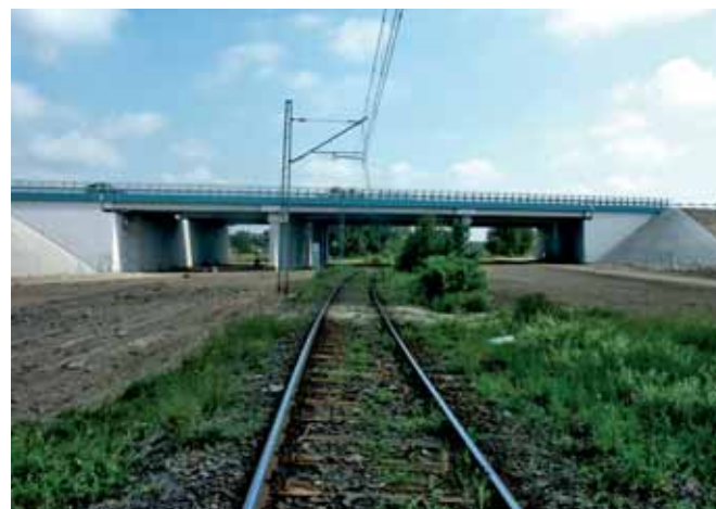
Wiadukt autostradowy na Autostradzie A2, odcinek Emilia - Stryków, obiekt WA-227
