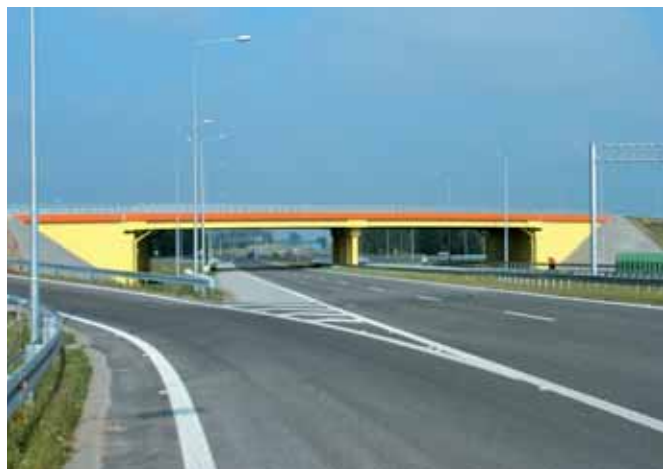
Wiadukt drogowy na Autostradzie A2, odcinek Emilia - Stryków, obiekt WD-215A w węźle Emilia
