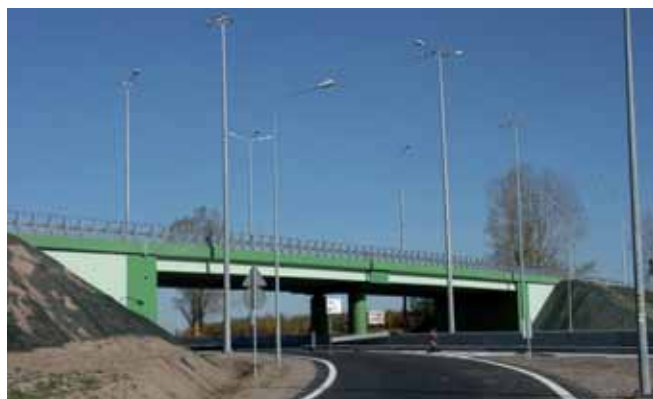
Rys. 1. Typowy obiekt w ciągu autostrady A4
