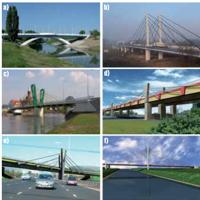
Rys. 3. Obiekty charakterystyczne o średnich rozpiętościach przęseł: a) most Zamkowy przez Wisłok w Rzeszowie (58,00 m) – 2002 r., b) wiadukt nad torami PKP w Poznaniu w ciągu ulicy Obronickiej (2 x 68,00 m) – 2003 r., c) most przez Nysę Kłodzką w Skorogoszczy w ciągu drogi krajowej nr 94 (2 x 59,75 m) – 2005 r., d) most przez Wartę w Koninie w ciągu drogi krajowej nr 25 (60,00 + 80,00 + 60,00 m) – w budowie (wizualizacja), e) wiadukt nad autostradą A4 w ciągu drogi krajowej nr 94 (45,47 + 45,28 m) – planowany (wizualizacja), f) most przez San w Przemyślu – planowany (wizualizacja)
