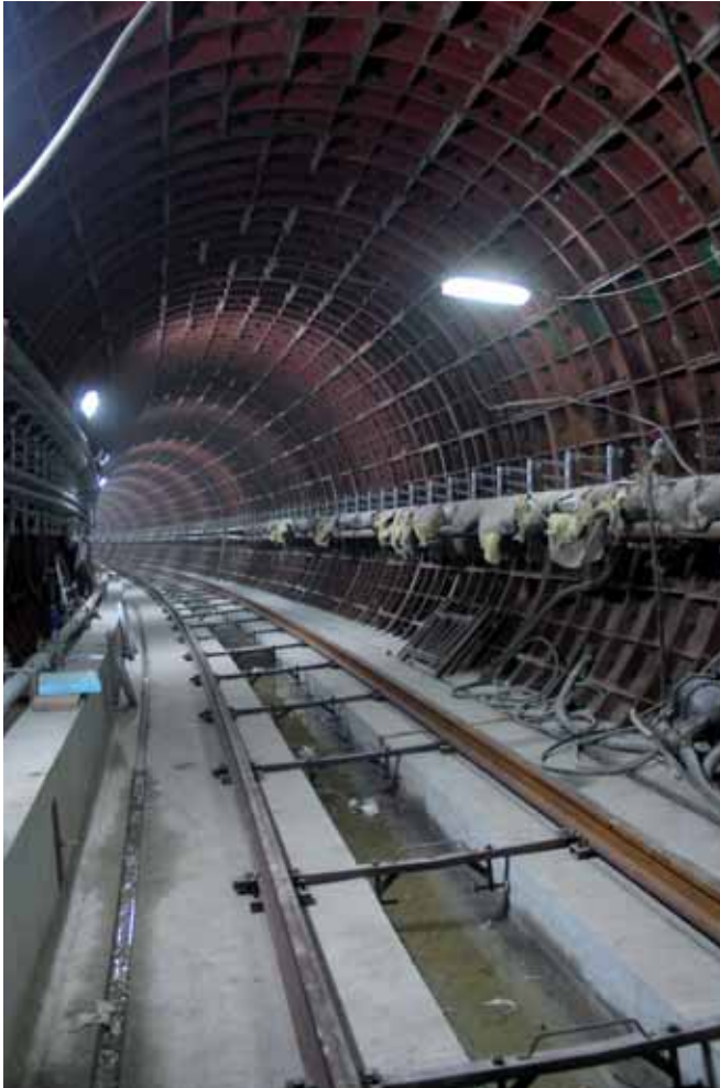
Tunel szlakowy metra w trakcie realizacji
