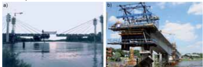
Rys. 6. Most Tysiąclecia we Wrocławiu: a) w trakcie betonowania wspornikowego mostu podwieszono, b) w trakcie betonowania wspornikowego mostu nawisowego
