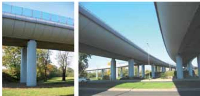
Rys. 10. Estakady we Wrocławiu w ciągu Obwodnicy Śródmiejskiej
