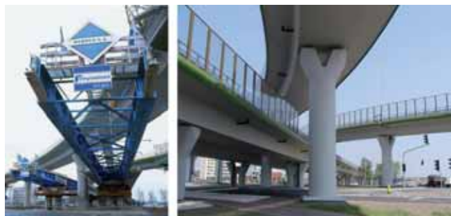
Rys. 11. Wiadukty na Węźle Czerniakowska w ciągu Trasy Siekierkowskiej w Warszawie
