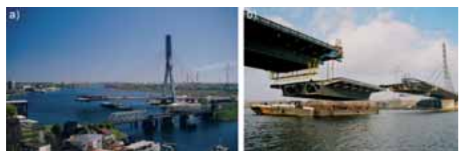
Rys. 8. Montaż nawisowy przęsła: a) mostu Martwą Wisłę w Gdańsku, b) mostu przez Wisłę w Płocku
