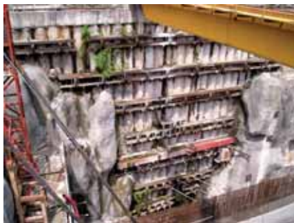
Rys. 3. Ściana z wbijanych pali zabezpieczająca wykop w miejscu wykonywania szybu wentylacyjnego [7]
