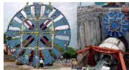
Rys. 4. Montaż tarczy urabiającej o ciężarze 3000 kN [3]
