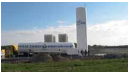
Ryc. 8. Instalacja LNG. Dostawa LNG
