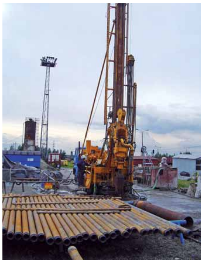
Stanowisko wiertnicze dla wykonania otworu technicznego w kopalni „Pniówek”
