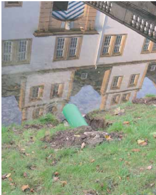
Pierwsza rura zainstalowana w rowie
