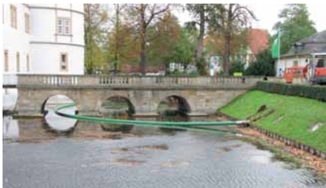
Zmontowane i gotowe do instalacji rury w rowie
