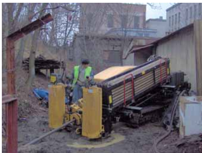
Maszyna wiertnicza VERMEER D24x40IIA w trakcie realizacji zadania
