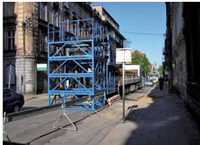
Montaż wieży inwersyjnej
