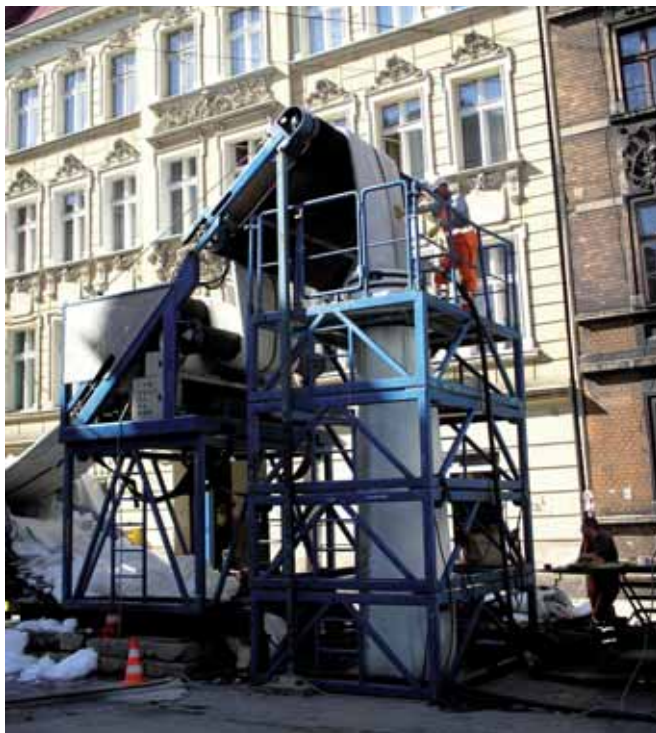
Napełnianie rękawa wodą z hydrantu
