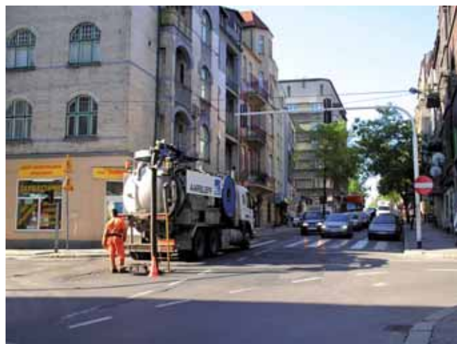
Prace przygotowawcze – czyszczenie kanału wozem wysokociśnieniowym
