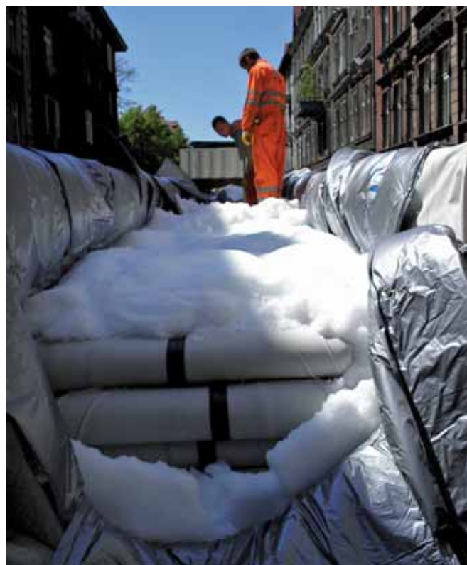
Dowóz rękawa zabezpieczonego lodem przed samoistnym utwardzeniem
