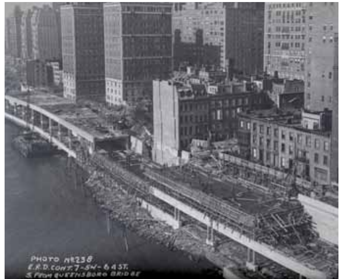
Ryc. 2. Zaawansowana budowa trzydziemiejowej estakady pomiędzy ulicami 54. a 63. w latach 1939–1940
