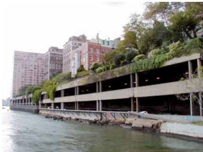
Ryc. 4. Widok omawianego odcinka FDR Drive
