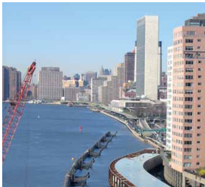
Ryc. 6. Gotowa rampa objazdowa w nurcie rzeki z widocznym systemem kotwionych odbojnic dla jednostek pływających
