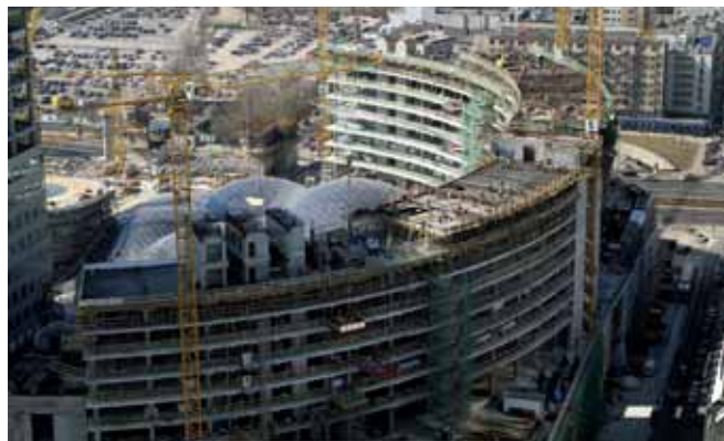
Roboty konstrukcyjne przy budowie biurowca Lumen – marzec 2005
