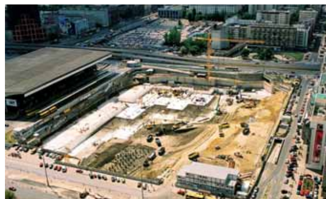
Wykonanie płyty fundamentowej – lipiec 2003
