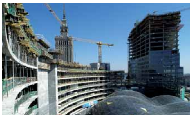
Wykonywanie konstrukcji żelbetowej biurowca Lumen oraz szklanej fasady wieżowca biurowego – marzec 2005
