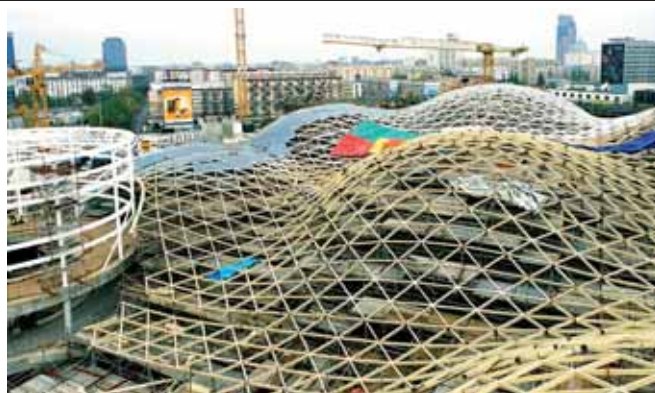
Konstrukcja stalowa dachu atrium – październik 2004
