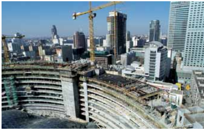
Wykonywanie stropu kondygnacji biurowca Lumen – marzec 2005
