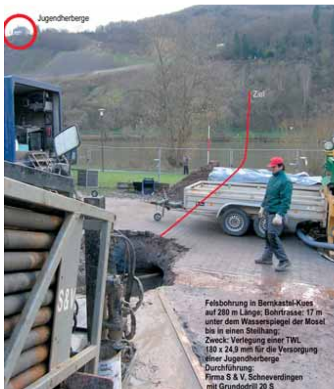
Trasa przewiertu od strony startowej, po lewej stronie widoczna wiertnica
