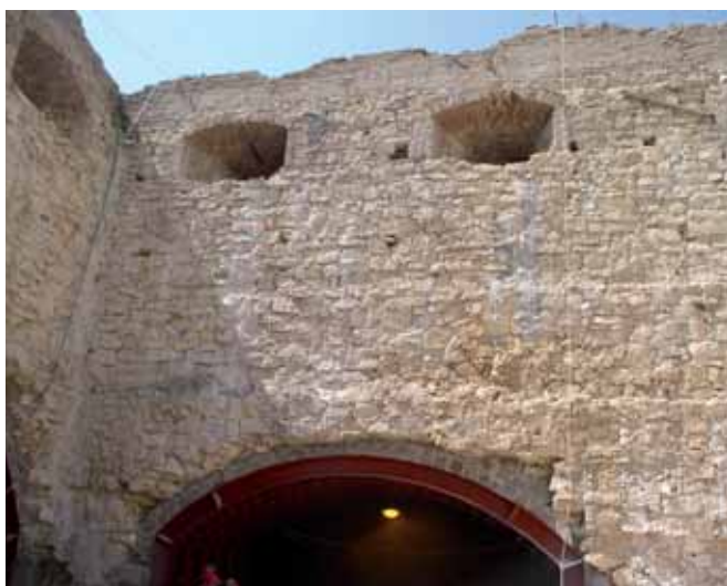
Ryc. 6. Wzmacnianie murów bastionu św. Barbary na Jasnej Górze
