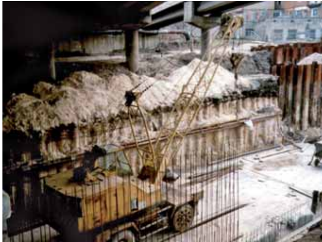
Ryc. 3. Pogłębienie koryta rzeki pod mostem w osłonie mikropali iniekcyjnych
