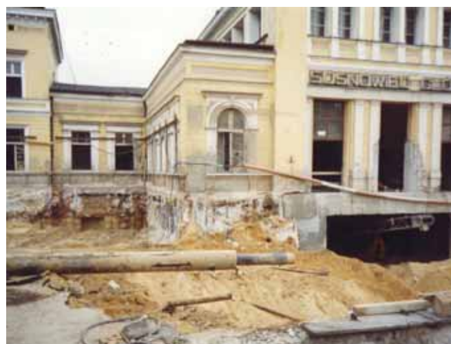
Ryc. 11. Iniekcja strumieniowa jet grouting pod fundamentami budynku dworca kolejowego w Sosnowcu
