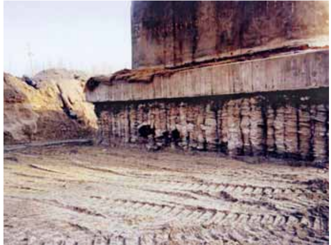
Ryc. 5. Nowe posadowienie filaru mostowego
