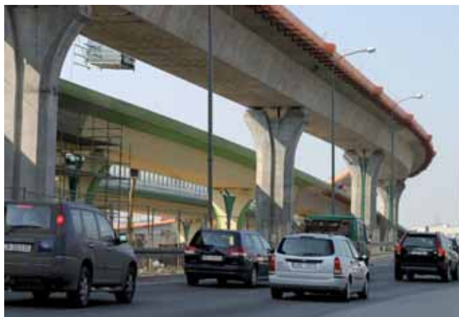
Widok na estakadę OE-1 z ul. Ostrobramskiej
