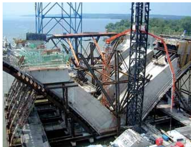
Fot. 6. Budowa podpory dla prześla podnoszonego
