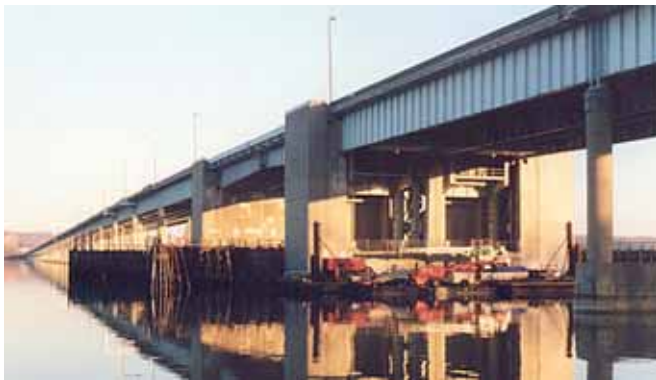
Fot. 1. Stara konstrukcja z 1961; dla każdego kierunku ruchu zaprojektowano po dwa dźwigary z poprzecznikami, na których oparto ruszt stalowy podpierający żelbetowy pomost mostu
