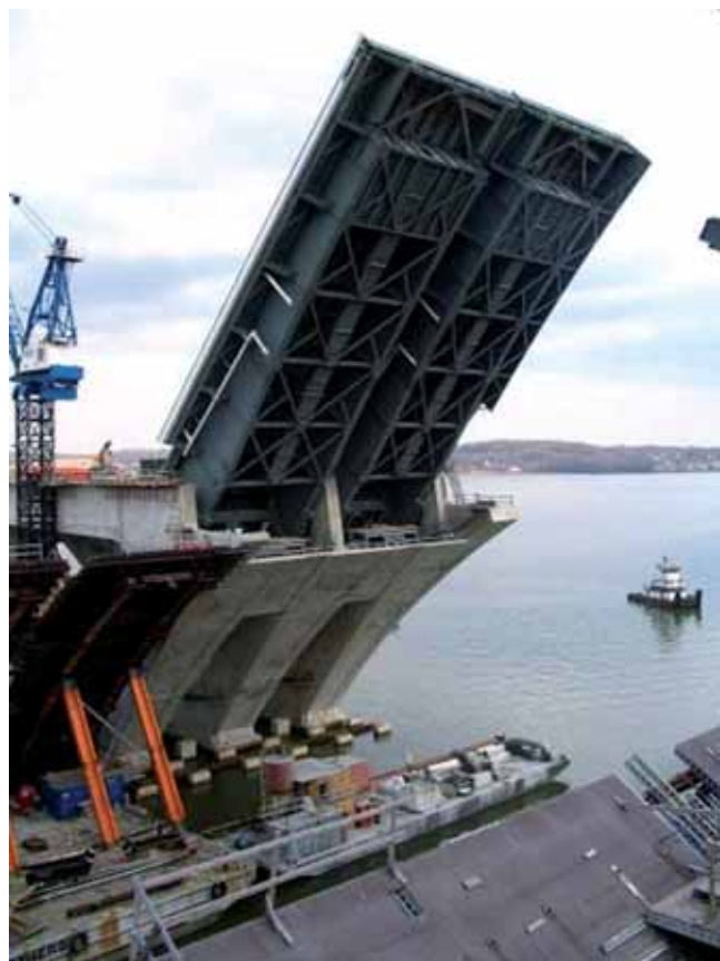
Fot. 9. Podniesione balastowane prześła mostu południowego. Na zdjęciu widać wyraźnie, że są to dwie połowy, które mogą być podnoszone lub opuszczane niezależnie. Projektując takie rozwiązanie zapewniono możliwość prowadzenia prac konserwatorskich bez konieczności całkowitego zamykania ruchu na moście
