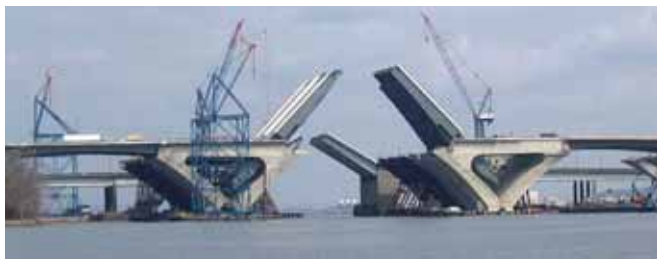
Fot. 7. Ukończone podpory prześel podnoszonych mostu południowego. Na drugim planie widoczne formy stalowe podpór mostu północnego, a dalej podniesione prześła starego mostu
