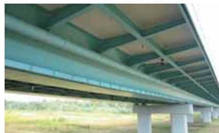
Ryc. 13. Odwodnienie obiektu mostowego przewodami z tworzywa GRP [3]
