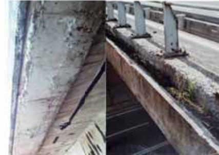
Ryc. 4, 5, 6, 7. Inne elementy konstrukcyjne mostu uszkodzone w wyniku braku odwodnienia [10]
