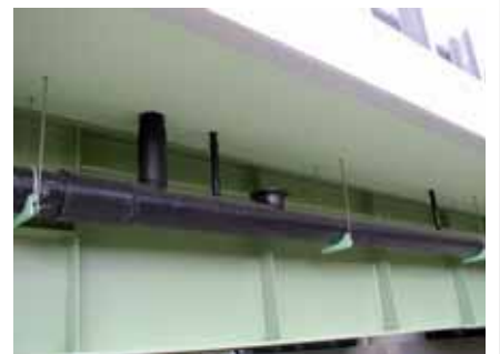
Ryc. 12. System odwodnienia obiektu mostowego wykonany z PE [3]
