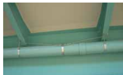
Ryc. 15, 16, 17. Stalowe konstrukcje mocujące [3]
