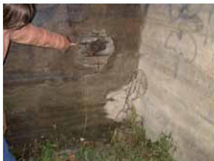
Ryc. 2, 3. Przyciótek. Widoczne zacieki oraz uszkodzenia ściany – ubytek betonu oraz niedrożny przewód odwadniający
