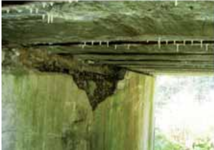
Ryc. 4, 5, 6, 7. Inne elementy konstrukcyjne mostu uszkodzone w wyniku braku odwodnienia [10]
