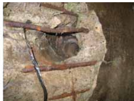
Ryc. 2, 3. Przyciótek. Widoczne zacieki oraz uszkodzenia ściany – ubytek betonu oraz niedrożny przewód odwadniający
