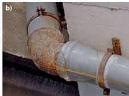
Ryc. 9. Kształtka żeliwna: a) zabezpieczona zewnętrzną i wewnętrzną antykorozyjną powłoką ochronną, b) bez zabezpieczenia antykorozyjnego [3]
