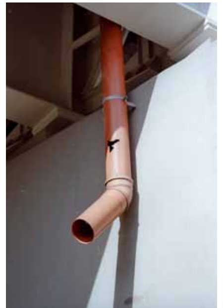
Ryc. 11. System odwodnienia obiektu mostowego wykonany z PVC-U [3]
