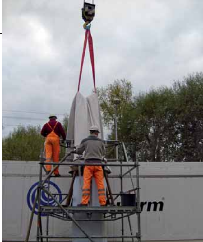
Wprowadzenie rękawa z tymczasowo wybudowanego rusztowania
