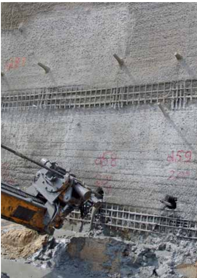
Ryc. 9. Instalacja gwoździa w otworze
