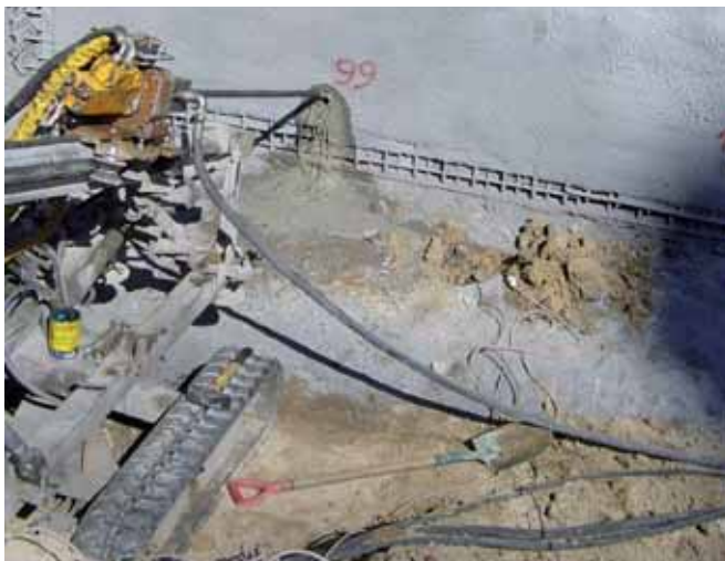
Ryc. 5. Instalacja kotwy w otworze
