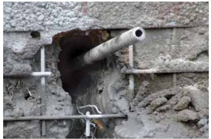
Ryc. 10. Zainstalowany gwoździe przed iniekcją końcową
