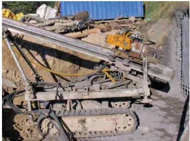
Ryc. 4. Mała wiertnica w wykopie o ograniczonej powierzchni
