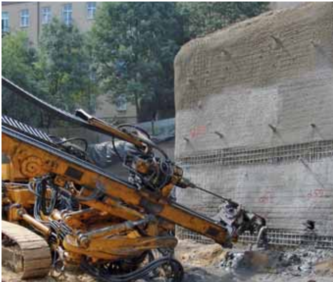
Ryc. 8. Instalacja gwoździa w otworze
