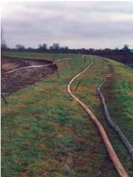
Rys. 4. Transport zawiesiny rurociągami ułożonymi na koronie wału
