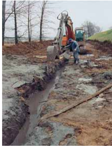
Rys. 5. Wykop szczelinowy wypełniony zawiesiną twardniejącą. Kontrola głębokości wykopu
