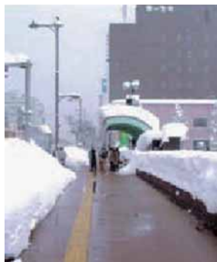
Rys. 1. Efekt działania geotermalnego ogrzewania chodnika [3]
