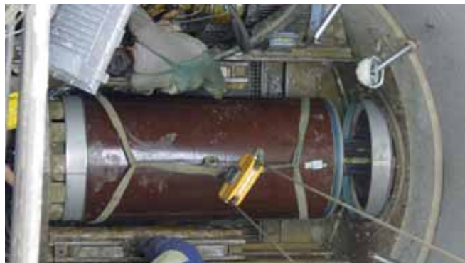
Gdańsk - lotnisko. Studnia startowa Ø 3,2 m. Najdłuższy odcinek 240 m
