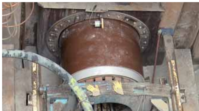
Warszawa Ø 1000. Studnia startowa 4 x 6 m. Najdłuższy odcinek 200 m
